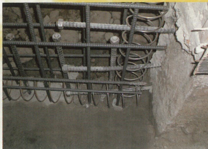
鉄筋コンクリート構造耐震壁の接合状況
