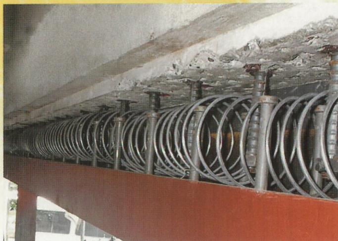
鋼構造耐震フレームの取り付け状況
